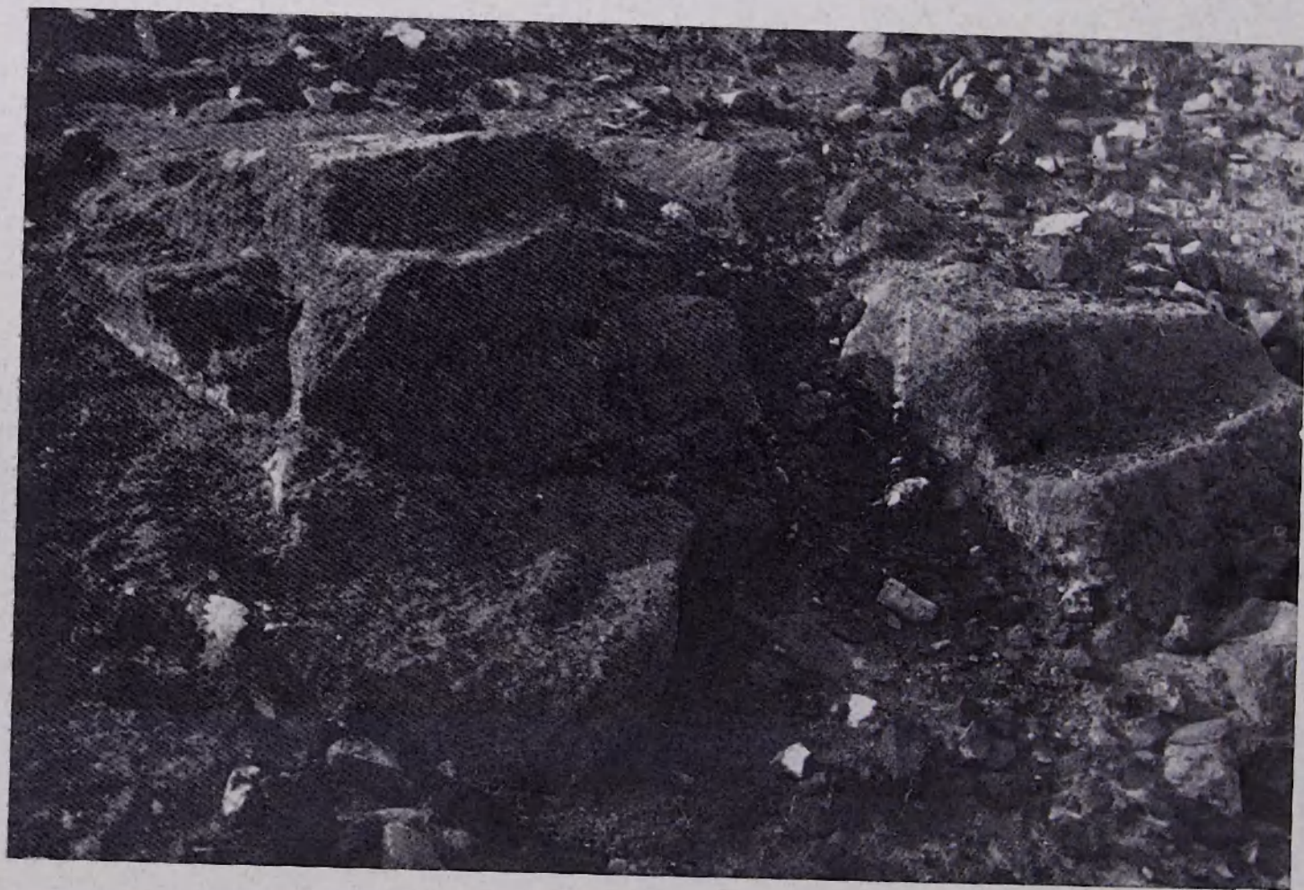
XXII. Обработанное скальное основание стен (зап. крепость).
